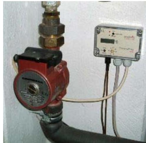
Mit ThermoPuls 1V30 nachgerüstete Wechselstrompumpe
