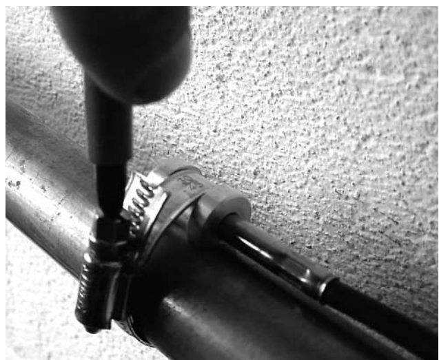
Bild 4 Montage des Temperaturfühlers mit beiliegendem Rohranlegeadapter
