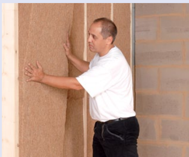
Einbau einer flexiblen Hanfdämmmatte
