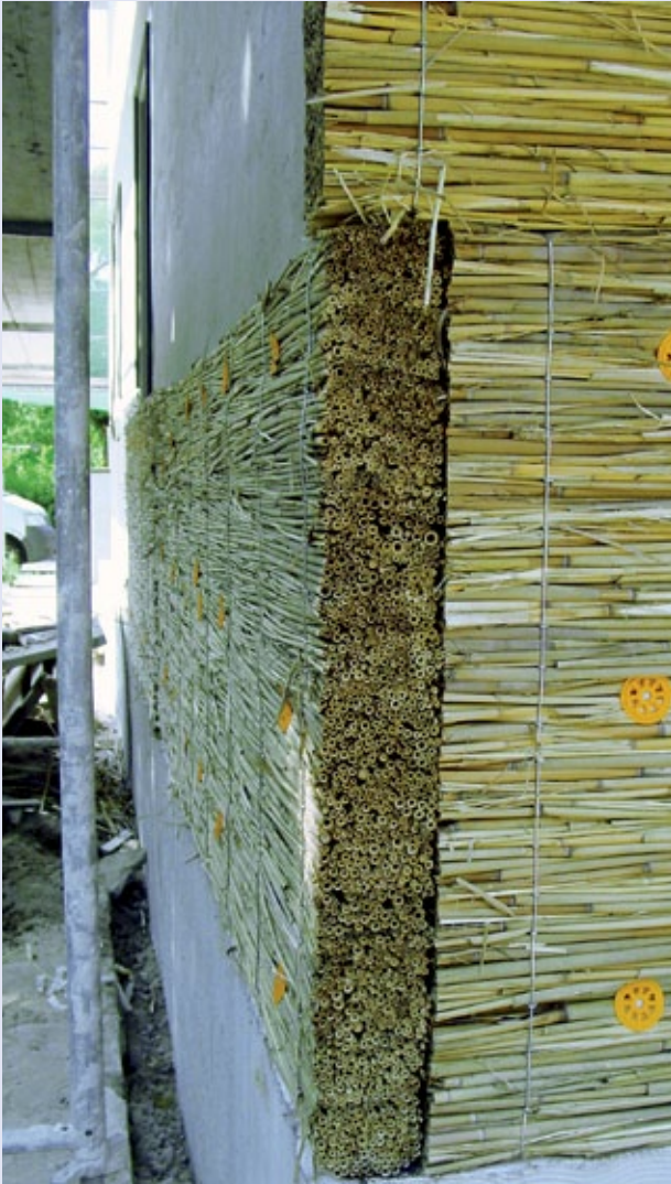
Mit Schilfplatten gedämmte Hausecke
