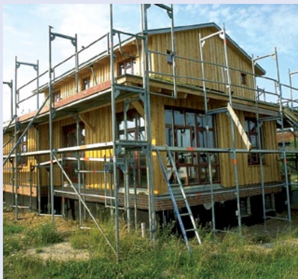
Holzhausbau mit Flachsdämmung
