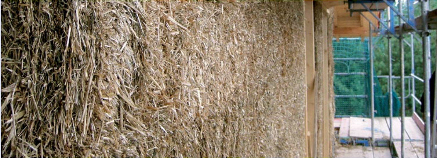
Strohballen zwischen einer Holzrahmenkonstruktion (außen)
