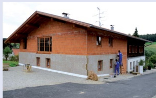
Außendämmung mit Holzwoleleichtbauplatte
