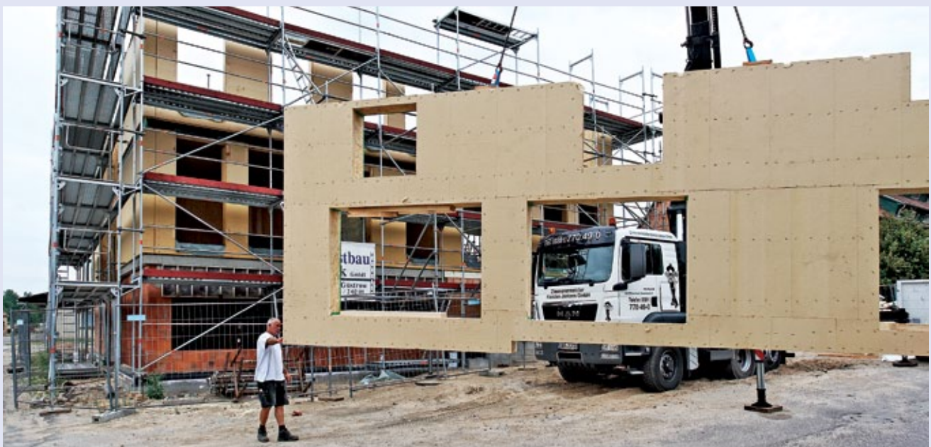
Vorgefertigte Außenwandelemente mit Holzfaserdämmung
