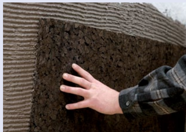
Einbau einer Innendämmplatte aus Kork
