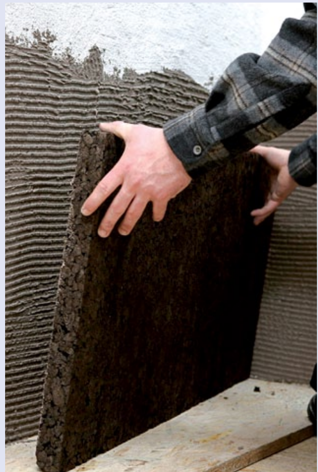
Innedämmung mit Kork-Dämmplatte
