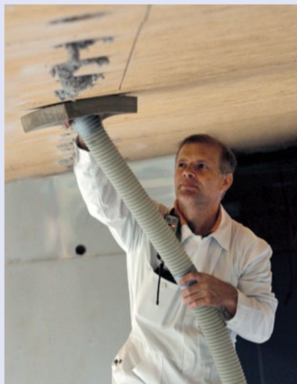
Zelluloseeinblasung in der Decke
