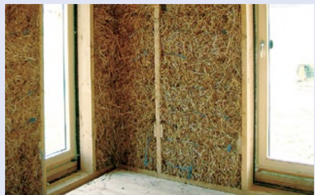
Innenansicht einer Holzrahmenkonstruktion mit Strohballen- dämmung
