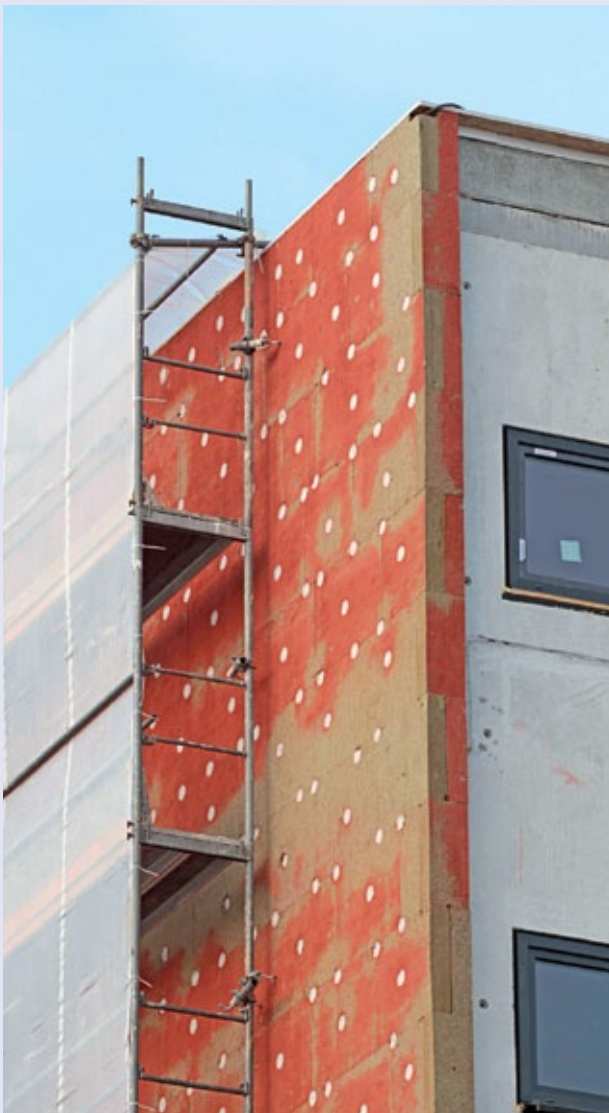
Dämmung der Außenwand
