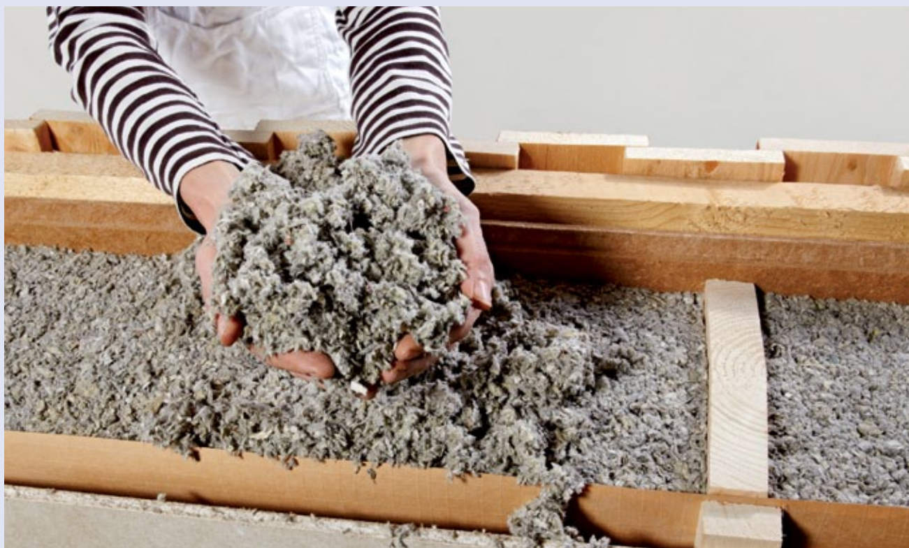
Zelluloseeinblasdämmung in einer Außenwand
