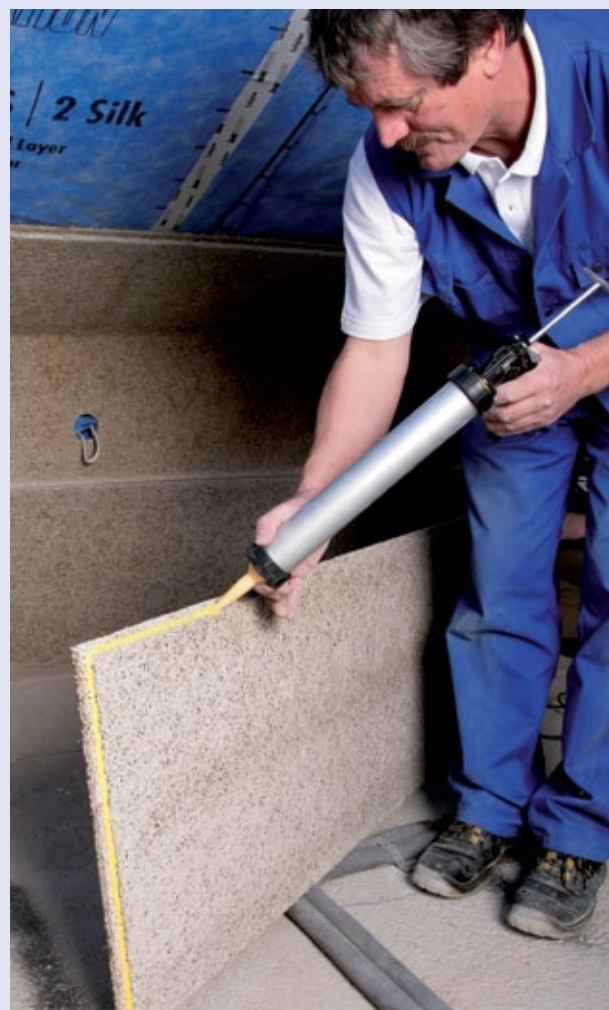
Montage der Holzwoleleichtbauplatte im Innenbereich
