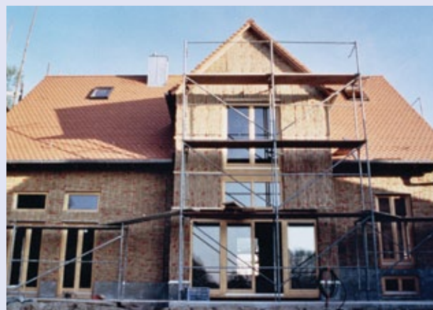
Schilf als Putzträger an der Außenfassade
