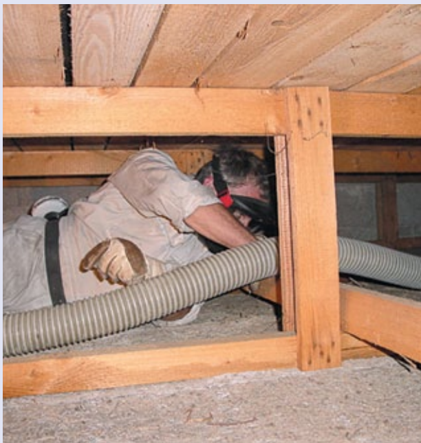
Vorbereitung zum Einblasen des Dämmstoffes
