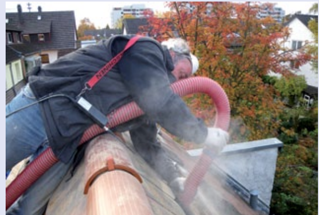
Einblasdämmung
