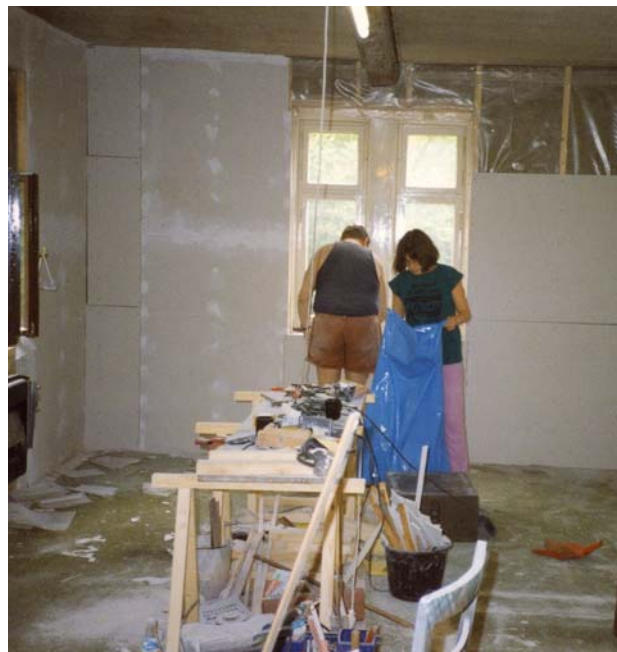
Montage einer Innendämmung in einem kleinen Bauernhaus Baujahr 1913 mit Mineralfaserdämmung, Dampfbremse und Gipskartonplatten.
