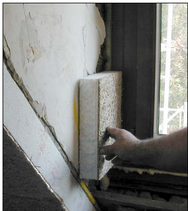
Die Dämmschicht wird, wie an dieser Gaubenwand, bis an den Fensterrahmen geführt.
