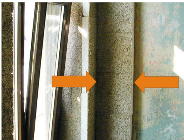
Dämmung einbindender Innenwände und Massivdecken mit einer 40cm breiten Dämmschürze
