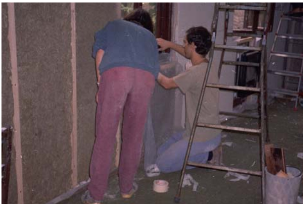
Innendämmung aus Mineralfaserplatten mit Dampfbremse; hier die Herstellung des Anschlusses am Fensterrahmen
