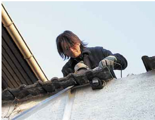
Geflext hatte Praktikantin Katja Hammer vorher noch nie. Aber für den Kollektor musste Platz geschaffen werden.
