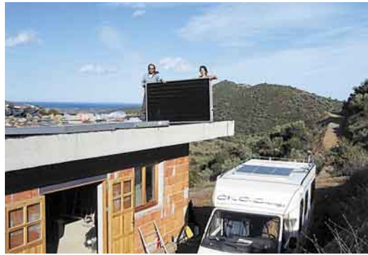
Highlight: Montage von Solarabsorbemern auf Sardinien. Den Strom für die Arbeiten lieferte die 160-Watt-Photovoltaik-anlage auf dem Dach des Transporters.
