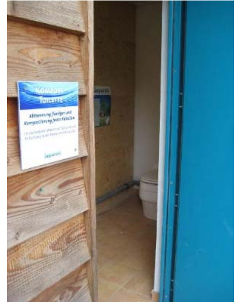
Die Separett Villa Trenntoilette im Umweltzentrum Fulda
