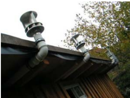
Savoniusrotor Windlüfter der TC-Anlage in Osnabrück
