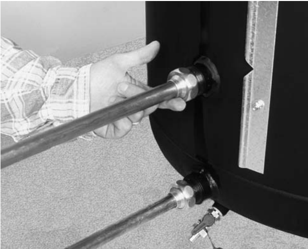
Bild 25 Nach Inbetriebnahme alle Anschlüsse (auch an Konvektionsbremsen), Flansch und Anodenverschraubung auf Dichtigkeit prüfen und ggf. nachziehen.
