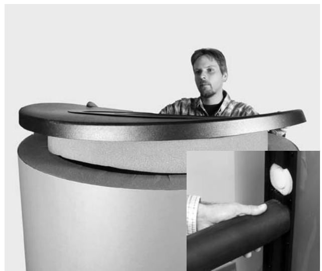
Bild 30 Die beiden oberen Isolierscheiben einsetzen und Deckel auflegen. Angeschlossene Rohre isolieren und Isolierschläuche fest an die Speicherdämmung drücken
