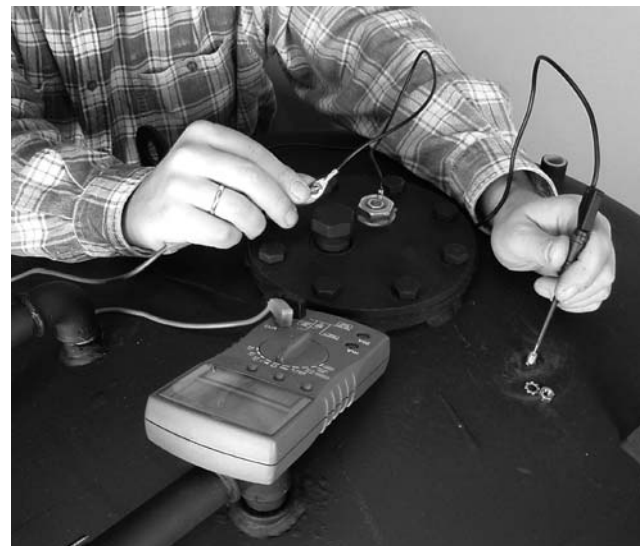
Bild 31 Die werkseitig eingeb. Magnesium-Schutzanode alle 2 Jahre überprüfen. Kabel abziehen und mit Multimeter Stromfluss messen: Kleiner 0,3 Milliampere = Anode kontrollieren und ggf. erneuern.
