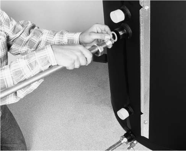
Bild 13 Solarkreis mit Vor- und Rücklauf anschließen. Der Eintritt in den Solarkreis-Wärmetauscher ist oben und der Austritt unten.
