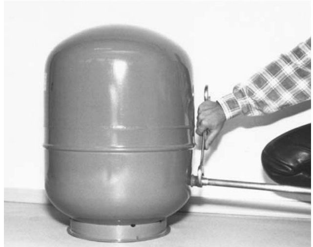
Bild 20 Beachten Sie, dass zur Aufnahme der Wärmeausdehnung des Speicherinhalts ein entsprechend großes Ausdehnungsgefäß im Heizkreis installiert werden muss (siehe Tabelle 3).
