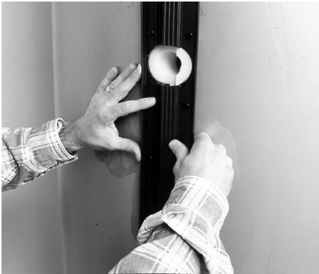
Bild 3 Isolierung an Hakenleiste öffnen, beiseite stellen, Speicher von Palette schrauben und am Standort aufstellen.
