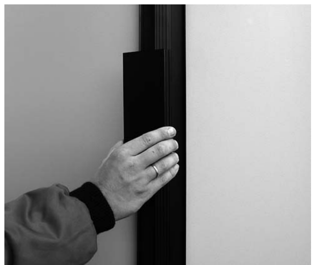
Bild 28 Die den Anschlüssen gegenüberliegende, hintere Hakenleiste der Manteldämmung einrasten. Hierzu ggf. Montagehilfe verwenden (Art.-Nr. 130 00 239) oder Hakenleiste mit Schrauben sichern.
