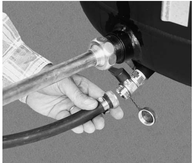
Bild 22 Zur Inbetriebnahme des Pufferspeichers erst unten am Speicher KFE-Hahn mit Schlauch verbinden und Wasser einströmen lassen.
