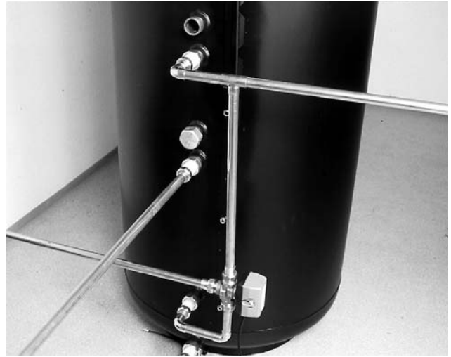
Bild 14 Option: Bei Systemlösung „Rücklauf Temperaturanhebung“ Umschaltventil nach Anschlussplan (Bild 1) einbauen.
