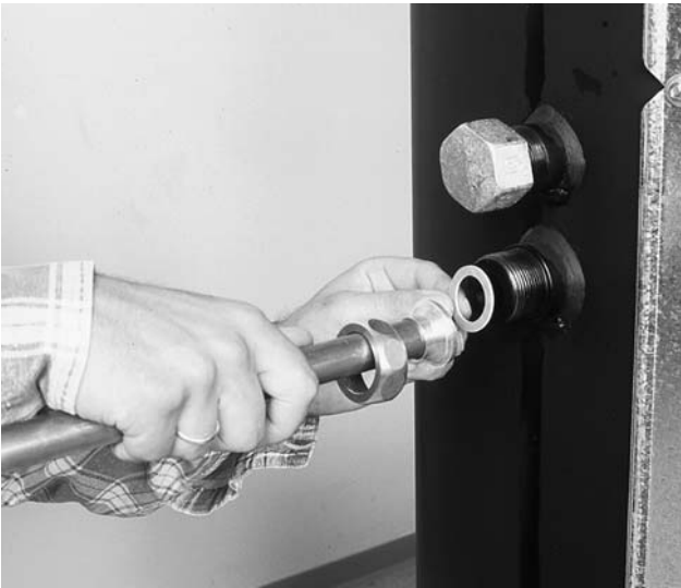
Bild 15 Je nach Systemlösung weitere Verbindungen montieren oder Kappen aufschrauben.
