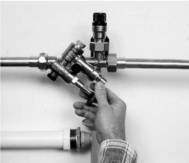
Bild 21 Zur Inbetriebnahme erst den Trinkwasser-Speicher befüllen. Zuerst Absperrhahn an Sicherheitsgruppe öffnen und dann auf Warmwasserseite Hahn aufdrehen, damit Luft entweichen kann.
