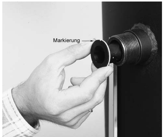
Bild 6 Beachten Sie bitte bei Installation der Konvektionsbremsen (im Speicheranschlusssatz) die dort beiliegende Montageanleitung
