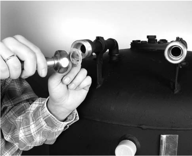
Bild 7 Linken Anschluss (rote Markierung) mit Warmwasser, rechten Anschluss (blaue Markierung) mit Kaltwasser verbinden.
