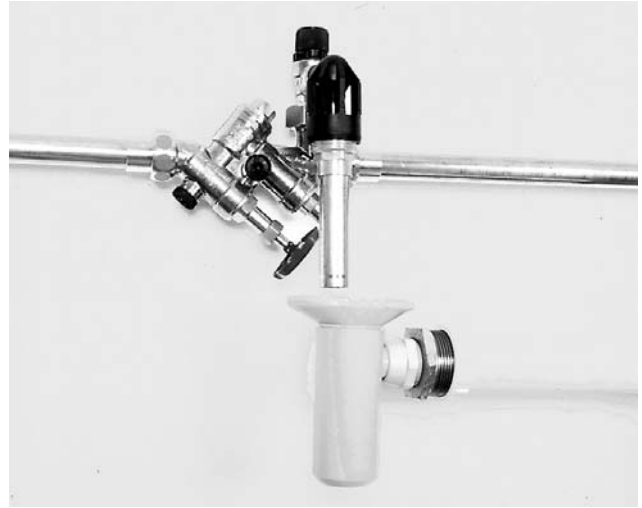
Bild 8 Option: In Kaltwasserleitung oberhalb des Speichers die Sicherheitsgruppe anstatt Absperr-, Rückschlag- u. Sicherheitsventil einbauen. Keine Absperrung zwischen Sicherheitsgruppe u. Speicher!
