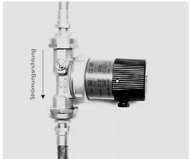
Bild 10 Option: Wenn gewünscht Brauchwasserzirkulations-Pumpe nach Anschlussplan einbauen und Rohranlagefühler möglichst nahe der letzten Warmwasserzapfstelle montieren.
