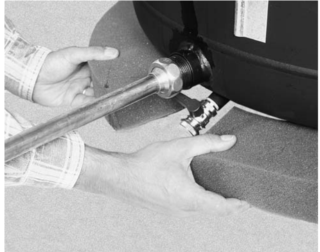
Bild 26 Jetzt unten Isolierring um den Speicher legen.
