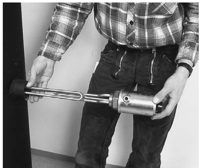
Bild 12 Option: Wenn erforderlich, elektrische Nachheizung einbauen. Zur elektrischen Installation siehe dem Heizstab beiliegende technische Information.
