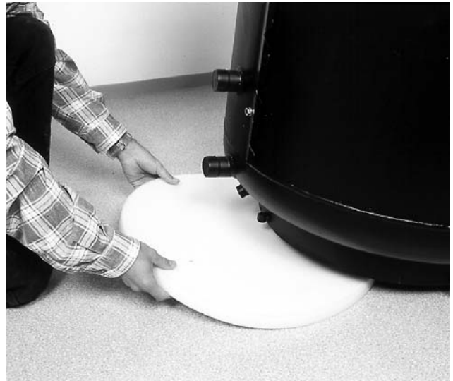
Bild 4 Speicher kippen und Innenteil der Bodenisolierung einlegen.
