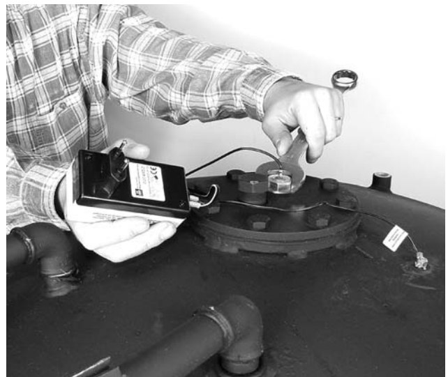
Bild 18 Option: Vom Elektronikgerät ein Kabel an Erdungsschraube befestigen und das andere auf die Elektrode stecken. Bedienungsanleitung der Fremdstromanode unbedingt beachten!
