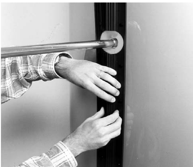
Bild 29 Isolierung mit der vorderen Hakenleiste schließen. Zunächst in die schwächste Nutposition einrasten und dann im Wechsel nachspannen.
