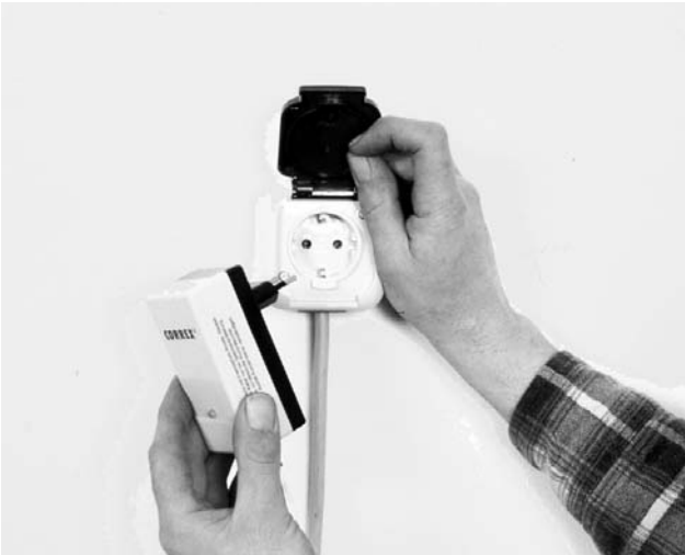
Bild 19 Option: Steckdose installieren und CORREX-Elektronikgerät einstecken. Wenn nach dem Füllen des Speichers grünes Licht leuchtet, ist alles okay. Bei rotem Blinklicht Bedienungsanleitung beachten.
