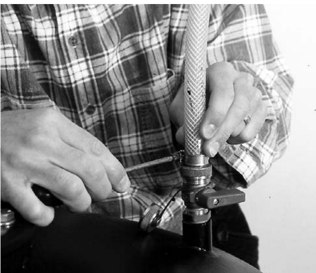
Bild 11 KFE-Hahn zum Entlüften oben am Deckel einschrauben, Schlauch überstülpen und mit Rohrschelle sichern.
