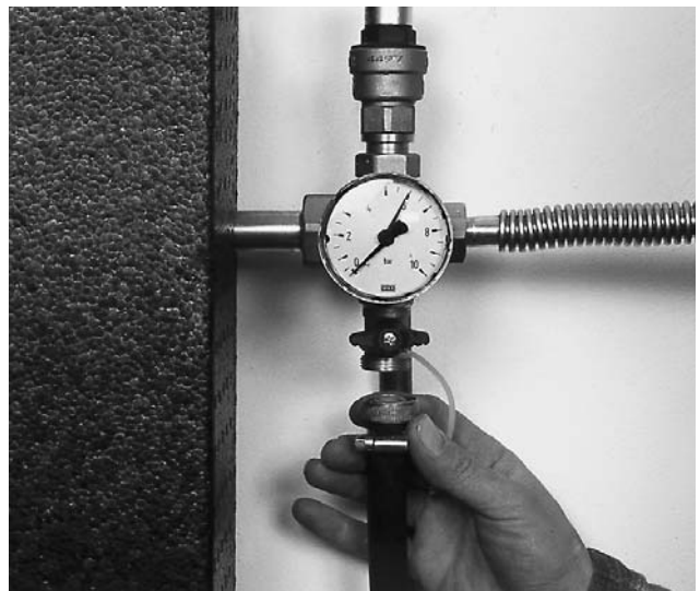
Bild 24 Solarkreis gründlich spülen, füllen und entlüften. Bitte Bedienungsanleitung zur Solaranlage beachten - insbesondere wegen des Frostschutzes im Solarkreis!
