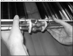
Nächstes Verbindungsblech anschrauben. Dabei muss das Kollektormodul dicht auf dem ersten Modul anstehen. Nächstes Kollektormodul analog montieren.
