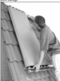
▶ Kollektor seitlich bündig am oberen Querprofil ausrichten
