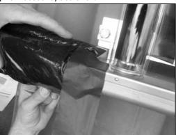
▶ Auf der Seite, auf der keine Leitungen angeschlossen werden, die Abschlusskappe aufsetzen:
