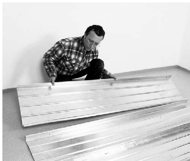
Bild 10 Kiesplatten (Stückzahl s. Tabelle 2) für die Bodenverankerung - alt. Betonsteine - auslegen. Wenn Winkelprofile mit Fundament verbunden werden, Dübel und Schrauben verwenden.
