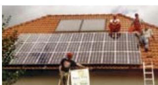
© Öko-Energie Photovoltaik hautnah: Monteure der Firma Öko-Energie installieren eine 2,8-Kilowatt-Anlage im hessischen Altenstadt.
