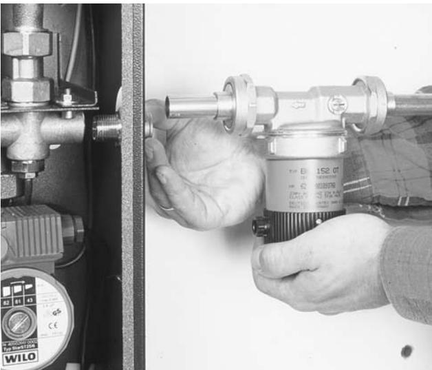
Bild 12 ... und Zirkulations-RL-Leitung nach Anschlussplan montieren. (Pumpe und Rückflussverhinderer bauseits erstellen.)
