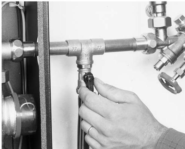
Bild 24 Station spannungsfrei schalten! Trinkwasserleitung drucklos machen und WW-Netz über bauseits inst. KFE-Hahn entleeren.
