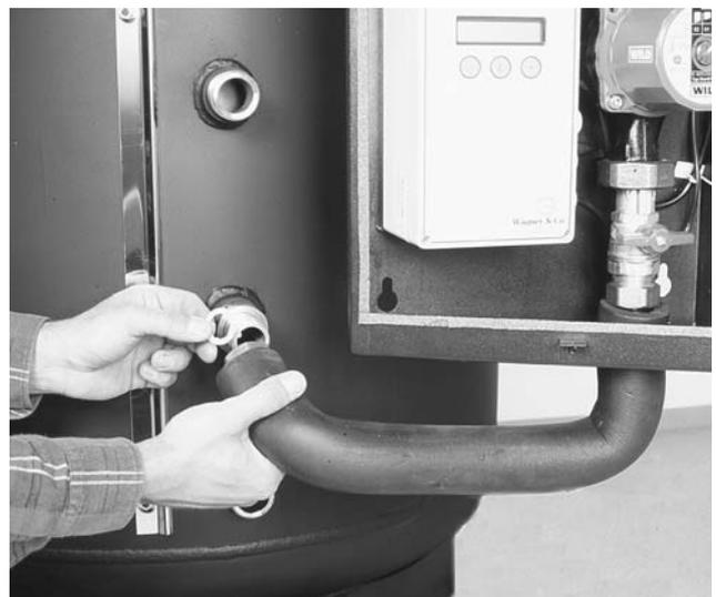
Bild 21 Anschließend zweiten Wellenschlauch am untersten Anschluss befestigen. Flachdichtungen nicht vergessen!
