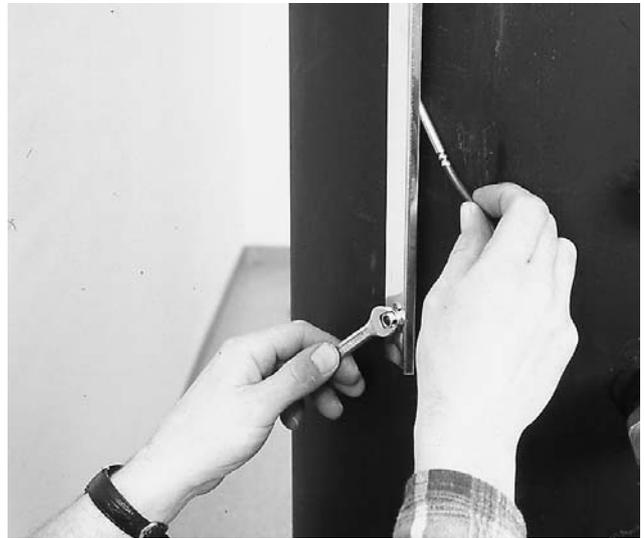
Bild 7 Im Nachheizbereich des Pufferspeichers den mit „Tprim“ gekennzeichneten Temp.fühler mit Klemmleiste oder Tauchhülse befestigen. Achtung! Fühler muss die Primärvorlauftemp. korrekt erfassen.
