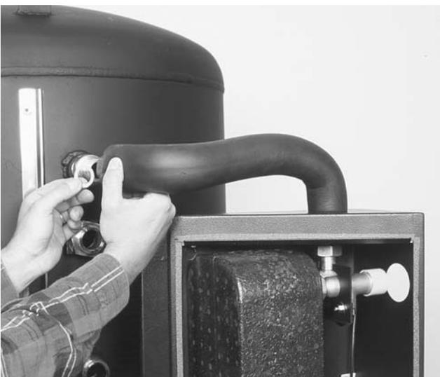
Bild 20 Als PVL Wellenschlauch am obersten Pufferanschluss montieren. Darauf achten, dass der Wellenschlauch zum Speicher hin stegig steigt, um eine Entlüftung zu ermöglichen.
