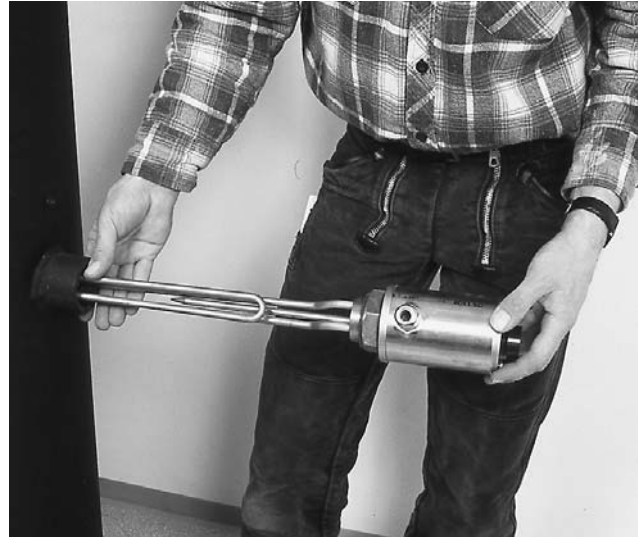
Bild 10 Option: Wenn erforderlich, elektrische Nachheizung einbauen. Zur korrekten elektrischen Installation siehe dem Heizstab beiliegende technische Information.
