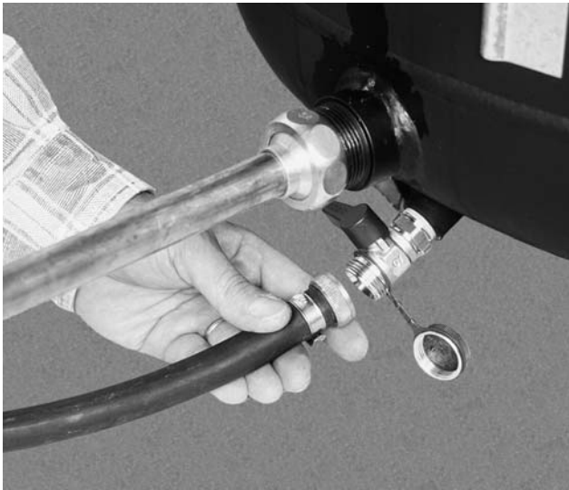
Bild 16 Zur Inbetriebnahme unten am Speicher KFE-Hahn mit Schlauch verbinden und Wasser einströmen lassen. Dann KFE-Hahn oben am Deckel aufdrehen, damit Luft entweichen kann.
