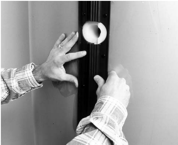
Bild 2 Transportschutzfolie entfernen, beim RATIO HP 500 Dämmung abnehmen durch Öffnen des Hakenverschlusses, geschützt zur Seite legen.
