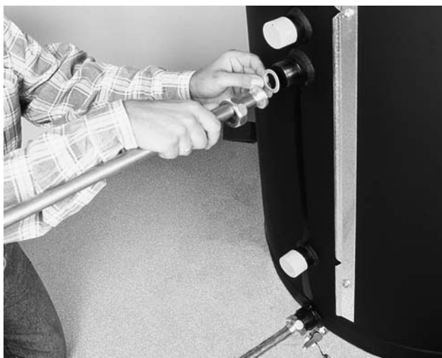
Bild 8 Bei Speicher mit Solarwärmetauscher: Solarkreis mit Solarwärmetauscher (Vorlauf und Rücklauf) verbinden. Der Eintritt in den Solarkreis-Wärmetauscher ist oben und der Austritt unten.
