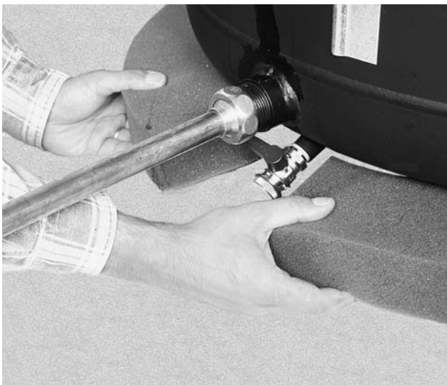
Bild 11 Zuerst unten Isolierring um den Speicher legen.
