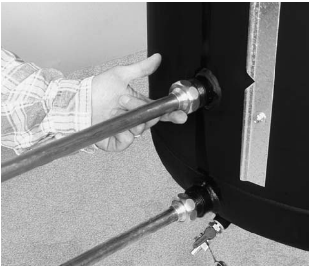
Bild 17 Nach Aufgabe des Prüfdruckes alle Verbindungen auf Dichtigkeit prüfen und ggf. nachziehen.
