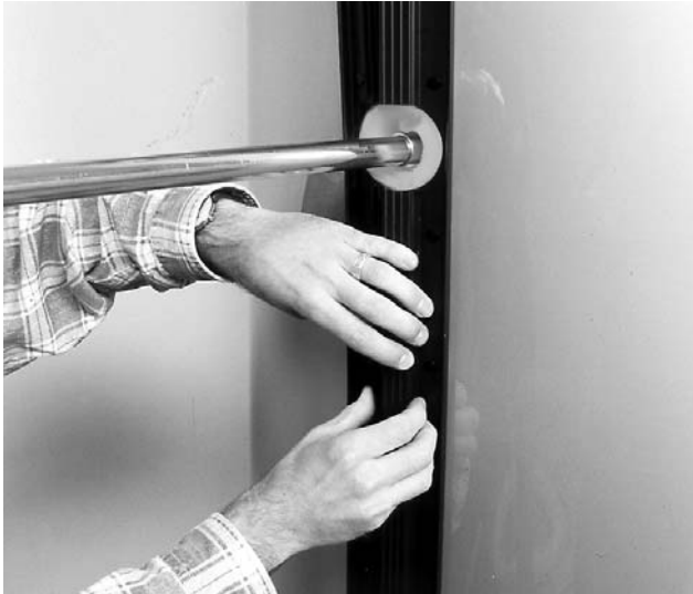
Bild 13 Isolierung mit der vorderen Hakenleiste schließen. Zunächst in die schwächste Nutposition einrasten und dann im Wechsel nachspannen
