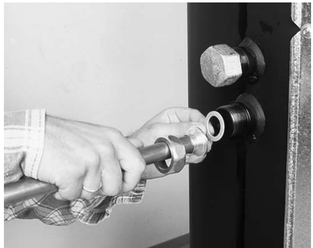
Bild 6 Je nach Systemlösung Heizungsanschlussrohre flachdichtend mit Speicher verbinden. Ungenutzte Speicheranschlüsse mit 5/4"-Kappen verschließen.
