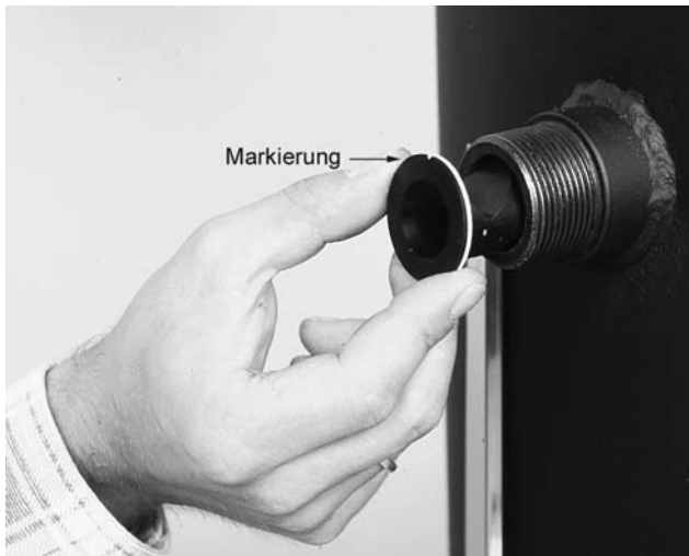
Bild 5 Beachten Sie bitte bei Installation der Konvektionsbremsen (im Speicheranschlusssatz) die dort beiliegende Montageanleitung
