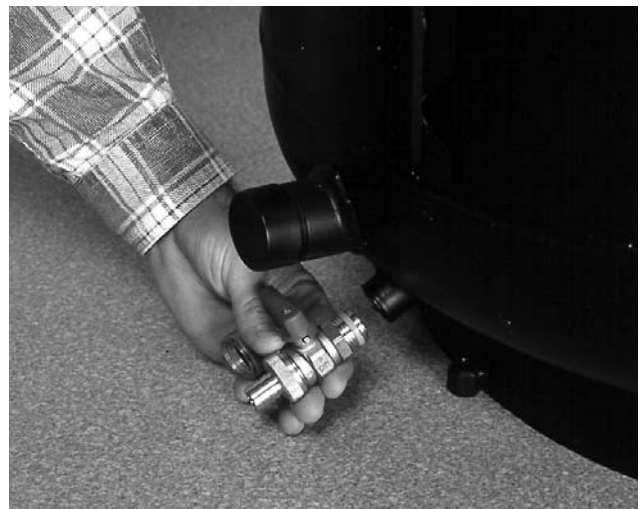
Bild 4 KFE-Hahn zum Füllen und Entleeren in den Anschluss am Boden einschrauben. Zur Entlüftung 5/4" - Anschluss im oberen Klöpperboden verwenden, z.B. KFE-Hahn mit Reduzierung oder Kappe.
