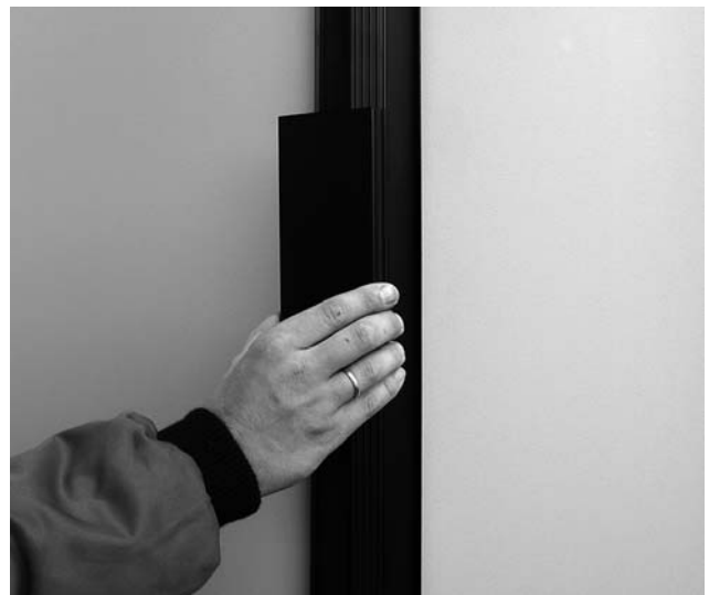
Bild 12 Die den Anschlüssen gegenüberliegende, hintere Hakenleiste der Manteldämmung einrasten. Hierzu ggf. Montagehilfe verwenden (Art.-Nr. 130 00 239) oder Hakenleiste mit Schrauben sichern.
