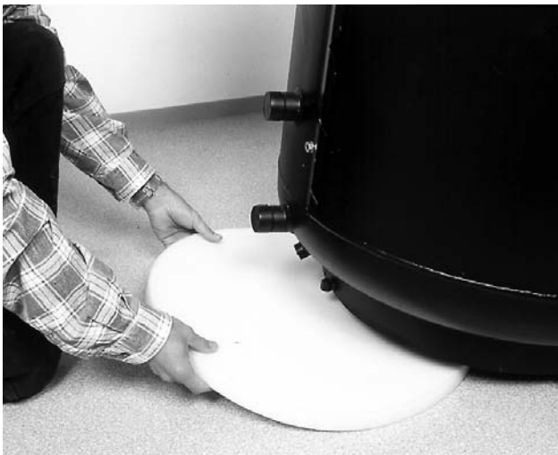
Bild 3 Behälter von der Palette schrauben und zum Aufstellungs-ort bringen (Gewicht bis 205 kg!). Behälter mit Anschlüssen zur Montage-wand drehen, kippen und Innenteil der Bodenisolierung einlegen.
