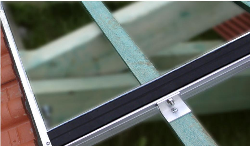
Die Abb. links zeigt die verschiebbare Montagewinkelbefestigung an der Systemschiene und der Dachlatte.
