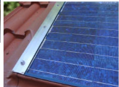
*Die Abb. zeigen den Einsatz des Schindelsystems als Teilfeld mit optionalem Wakaflex-Dachanschluß beziehungsweise eine Ganzdachlösung mit Blecheinfassung. Beides sind einfach zu realisierende Lösungen.*
