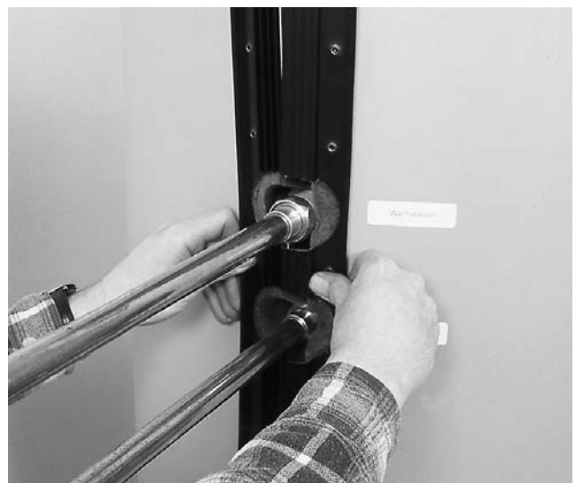
Bild 19 Isolierung mit Hakenleiste schließen. Zunächst in die schwächste Nutposition einrasten und dann im Wechsel nachspannen.
