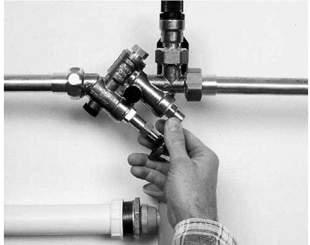
Bild 21 Zur Inbetriebnahme Speicher über Absperrhahn der Sicherheitsgruppe im Kaltwasserzulauf füllen. Auf der Warmwasserseite Hahn aufdrehen, damit Luft entweichen kann.
