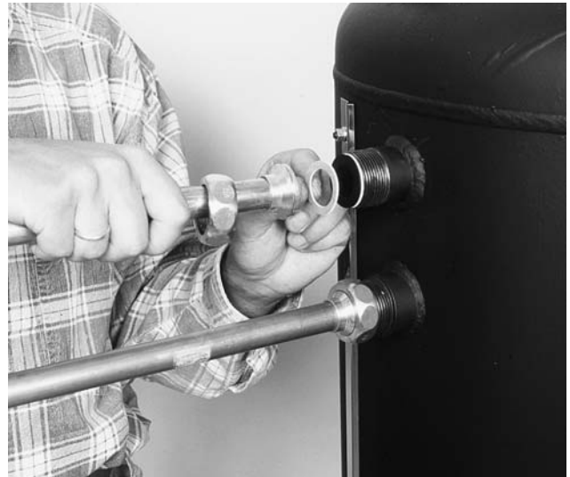
Bild 11 Warmwasserleitung oben am Speicher anschließen.
