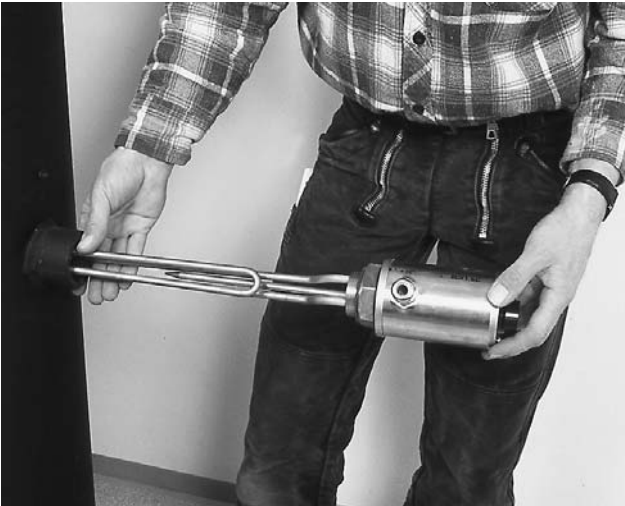
Bild 8 Option: Wenn erforderlich, jetzt elektrische Nachheizung einbauen. Zur elektrischen Installation siehe dem Heizstab beiliegende technische Information.
