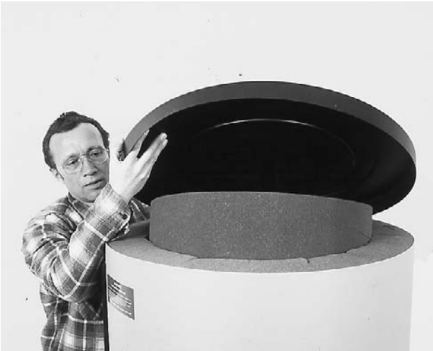
Bild 20 Obere Isolierrolle einsetzen und Deckel auflegen.
