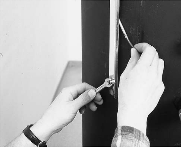
Bild 14 Temperaturfühler für Solarregler unter der Klemmleiste am Speicher festschrauben. Für optimale Regelung beachten Sie bitte Positionsmaße nach Tabelle 1.
