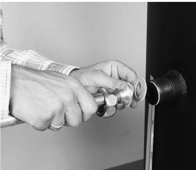
Bild 6 Solarkreis mit Vorlauf oben am Eintritt des Solar-WTs und mit Rücklauf unten am Austritt anschließen. Hierbei Flachdichtung mit Dichtungspaste einstreichen und Überwurfmutter fest anziehen.
