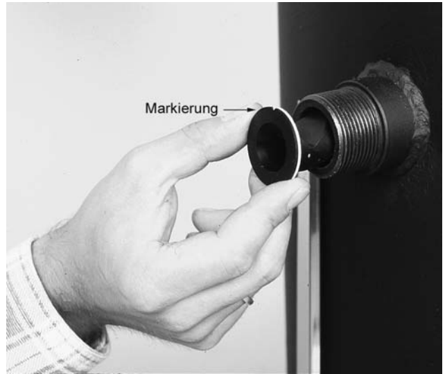
Bild 5 Beachten Sie bitte bei Installation der Konvektionsbremsen (im Speicheranschlusssatz), die dort beiliegende Montageanleitung.
