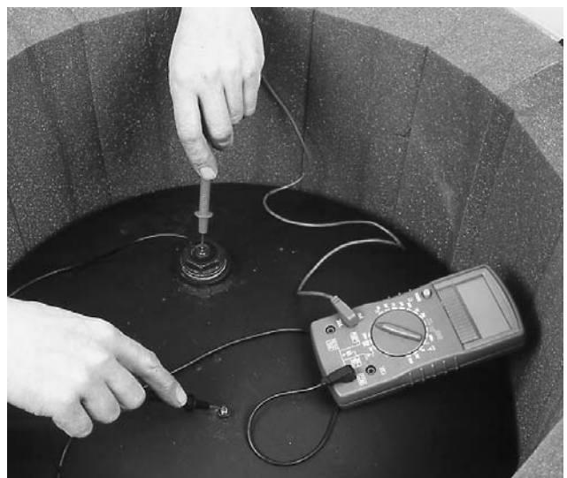
Bild 25 Die werkseitig eingebaute Magnesium-Schutzanode alle zwei Jahre überprüfen. Kabel abziehen und mit Multimeter Stromfluss messen. Bei weniger als 0,3 Milliampere Anode begutachten und ggf. erneuern.
