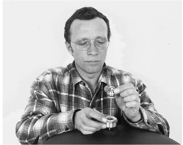
Bild 15 Option: CORREX-Fremdstromanode in Muffe am Speicherdeckel einschrauben. Vorher vorhandene Magnesium-Anode ausbauen. Keine Reduzierung bei CORREX mit 5/4" Gewinde nötig.
