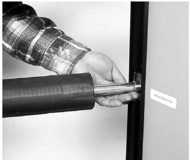
Bild 23 Nach Inbetriebnahme alle Anschlüsse (auch an Konvektionsbremsen), Flansch und Anodenverschraubung auf Dichtigkeit prüfen und ggf. nachziehen.
