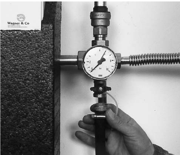
Bild 22 Solarkreis und Heizkreis gründlich spülen, füllen und entlüften. Bitte Bedienungsanleitung zur Solaranlage beachten - insbesondere wegen des Frostschutzes im Solarkreis!
