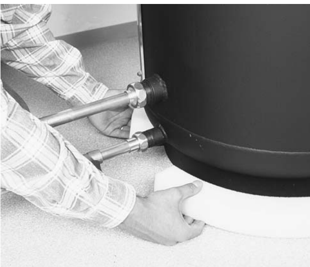
Bild 18 Jetzt unten Isolierring um den Speicher legen.
