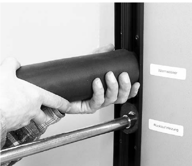
Bild 24 Am Speicher angeschlossene Rohre isolieren und Isolierschläuche fest an die Speicherdämmung drücken.
