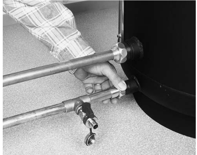
Bild 9 Kaltwasserleitung (mit KFE-Hahn zum Entleeren) unten am Speicher anschließen.
