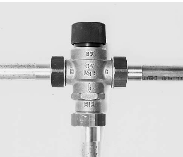
Bild 12 In Warmwasserleitung Brauchwassermischer zur Temperaturbegrenzung einsetzen. Anschlussbelegung siehe Aufdruck. Anschließend Rohre isolieren.
