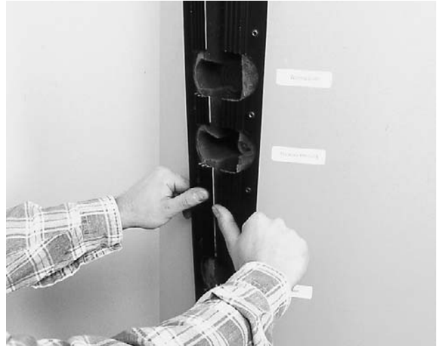
Bild 3 Isolierung an Hakenleiste öffnen, beiseite stellen, Speicher von Palette schrauben und am Standort aufstellen.
