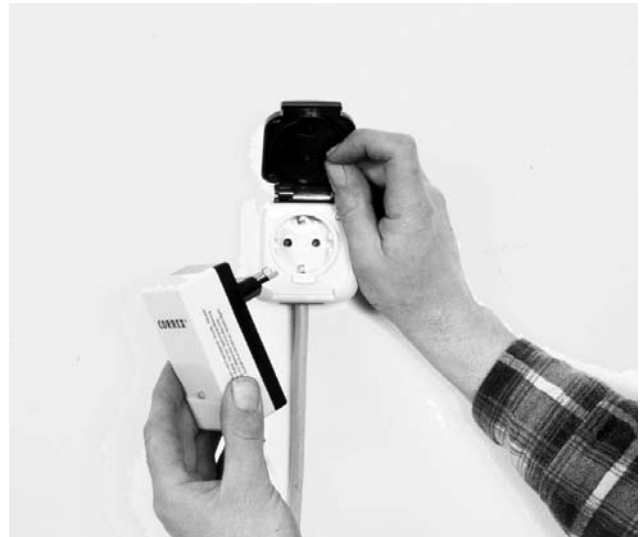
Bild 17 Option: Steckdose installieren und CORREX-Elektronikgerät einstecken. Wenn grünes Licht leuchtet, ist alles in Ordnung. Bei rotem Blinklicht Bedienungsanleitung beachten.
