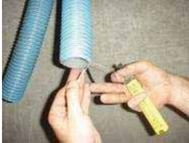
Bild 1 Erdung freilegen
