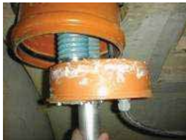
Bild 5 Einbau Adapterplatte
