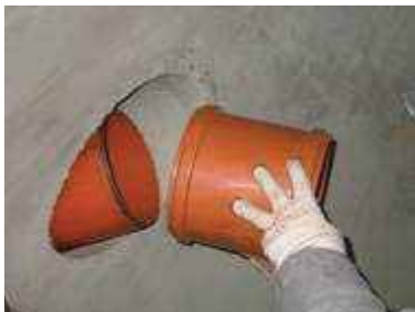
Bild 4 Muffe aufschieben
