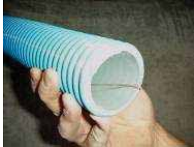
Bild 2 Erdung umbiegen
