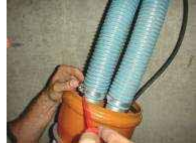
Bild 3 Schläuche anschließen
