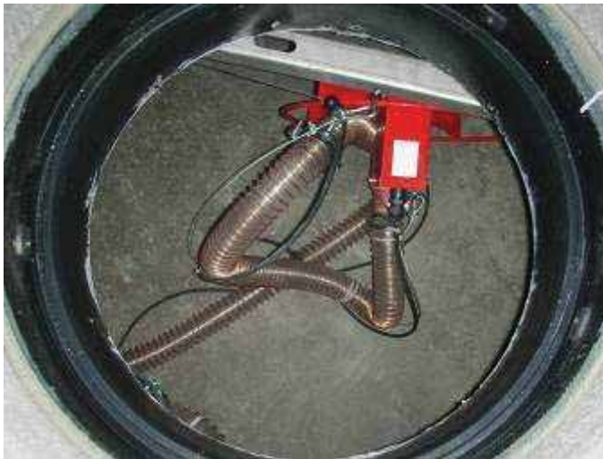
Bild 4 System in Parkposition für Befüllung
