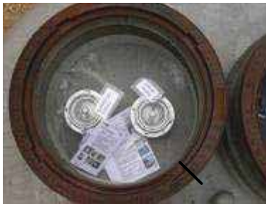
Bild 1 Füll/Absaugkupplung
