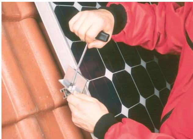
Bild 17 Befestigungsklemmen fixieren das Solarmodul einfach, schnell und sicher.
