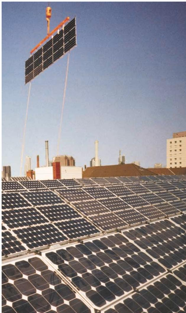
Bild 9 Flachdachmontage von Modulfeldern mit Autokran
