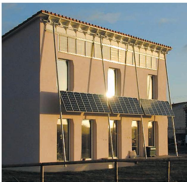
Bild 10 Wandmontage von solarmodulen – ein schöner Blickfang
