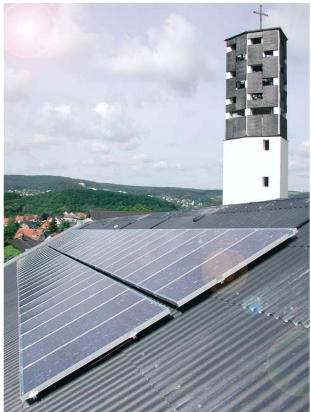
Bild 3 Aufdachmontage auf Berliner Welle
