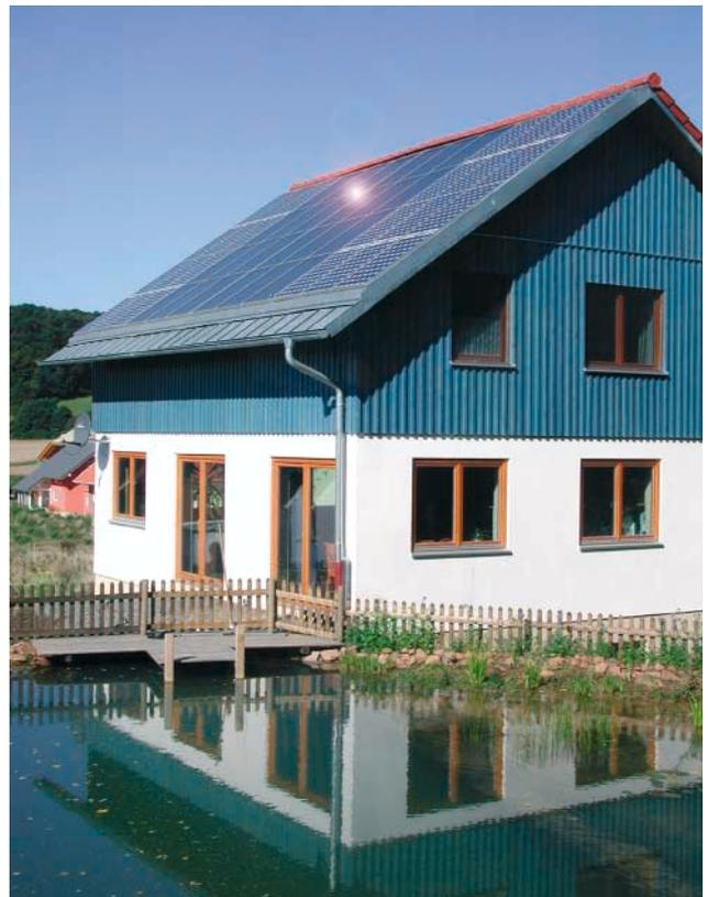
Bild 7 Indachmontage von Solarmodulen kombiniert mit themischen Kollektoren
