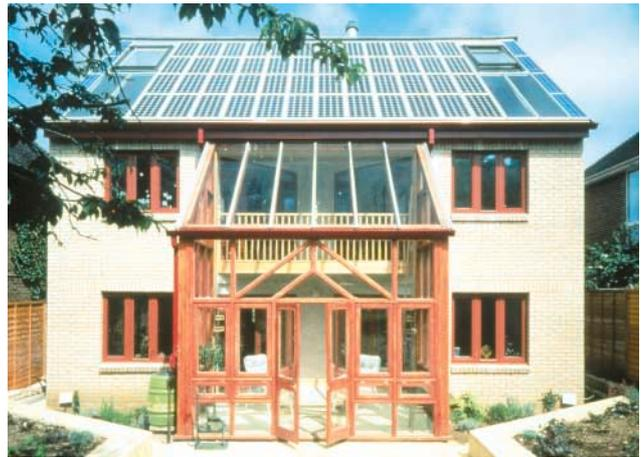
Bild 6 Indachmontage von BP-Solarmodulen
