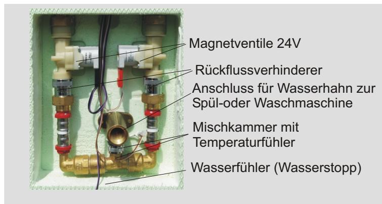
Wir haben aus Sicherheitsgründen einen Wasserstopp vorgesehen. Die Fühlerplatine wird im Unterputzmodul unten rechts eingelegt und angeschlossen. Eine weitere Verbindung führt zum Wasserfühler, der auf den Fußboden gestellt und an der Wasch-/Spülmaschine befestigt wird.
