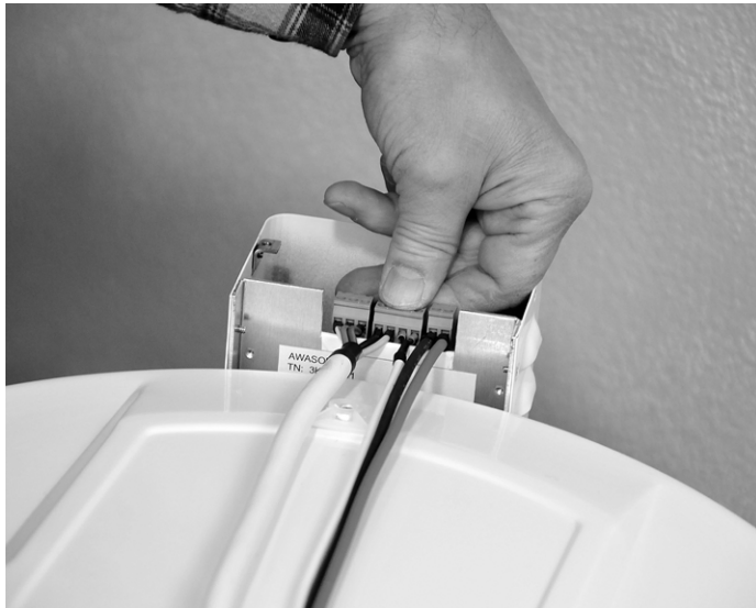
Abb. 9 Den Speicher-Kabelbaum einfach im Regler einstecken
